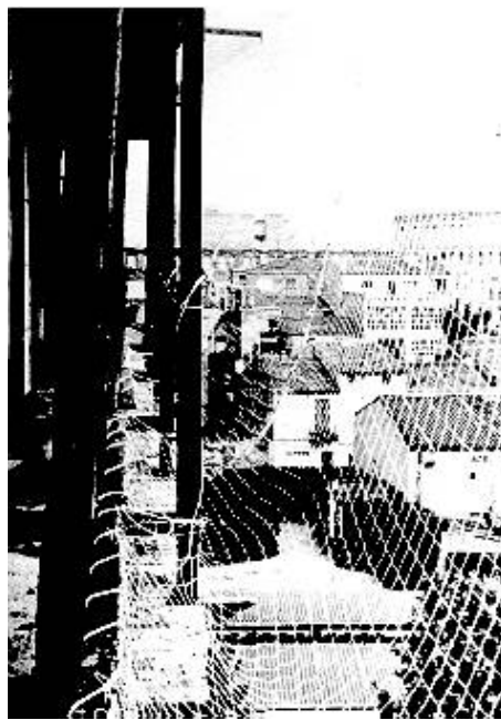
Fig. 7: Barra auxiliar de amarre de la red
