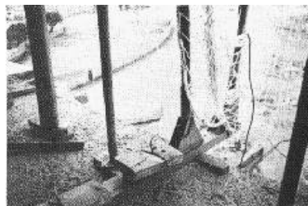
Fig. 15: Soporte sujeto al forjado con alambres
